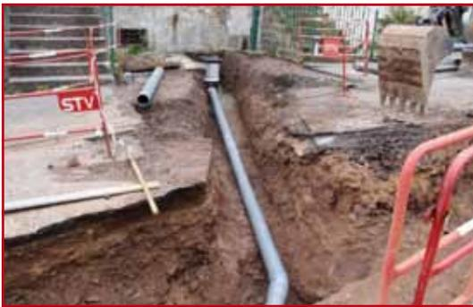
*Raccordement des Eaux Pluviales.*
